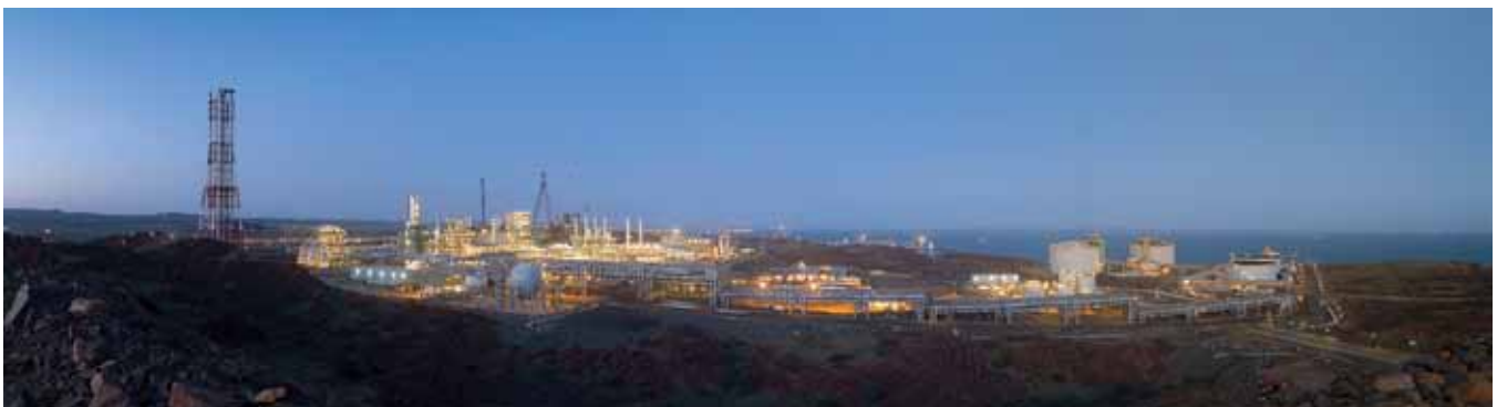
Pluto LNG Park.
